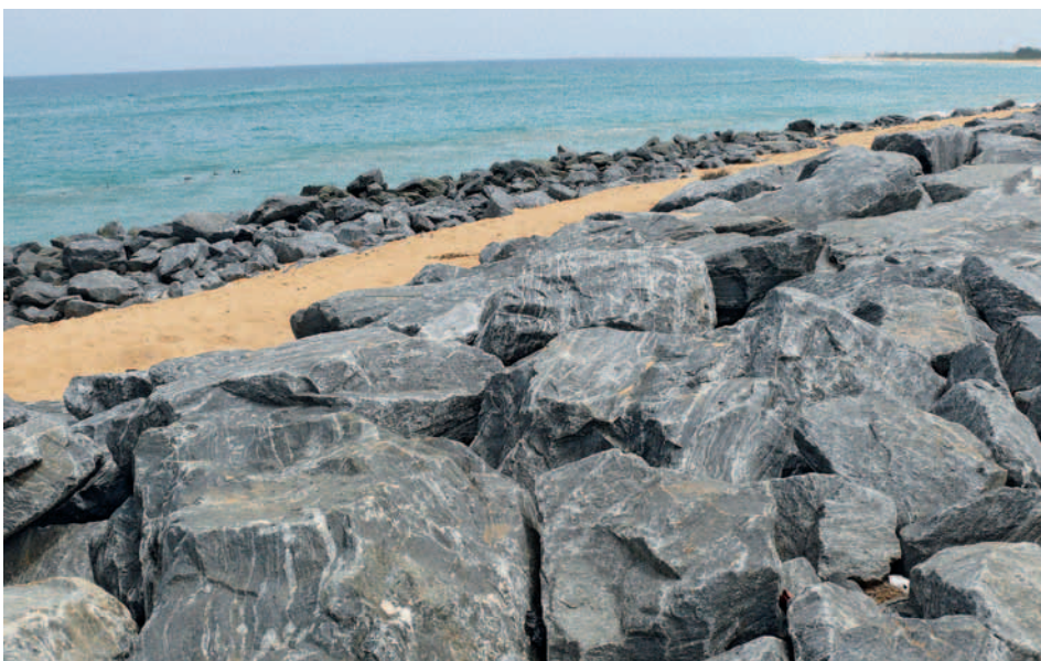
Mittlerweile ist ein Schutzwall gegen die Brandung errichtet worden. Foto: W. Blum
