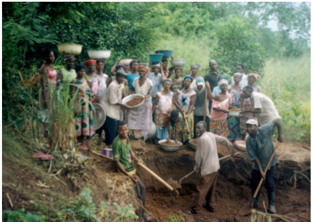
Alle Gemeindemitglieder halfen mit, das Haus für die Reisschälmaschine zu bauen.
